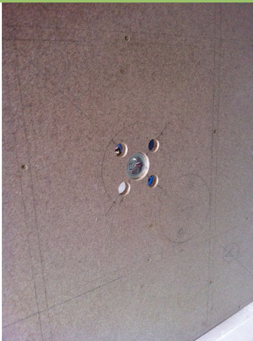
Fig. 10: Agujeros para led y racor de depósito.
