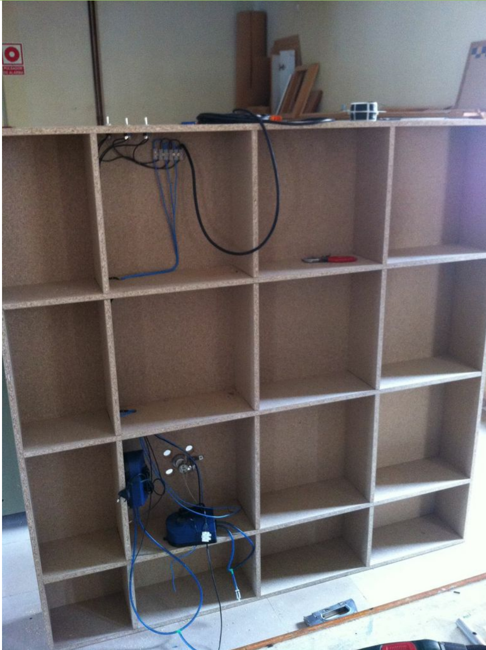
Fig. 11: Instalación del cableado y sujeción de elementos.
