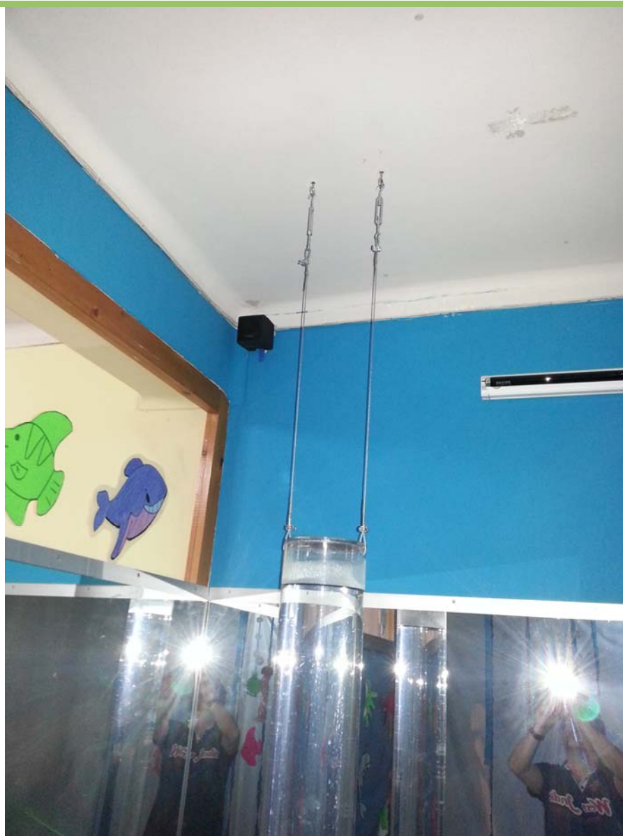
Fig. 16: Detalle del sistema de sujeción al techo.
