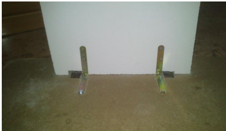
Apoyo posterior con bisagras sujetas a la base.
